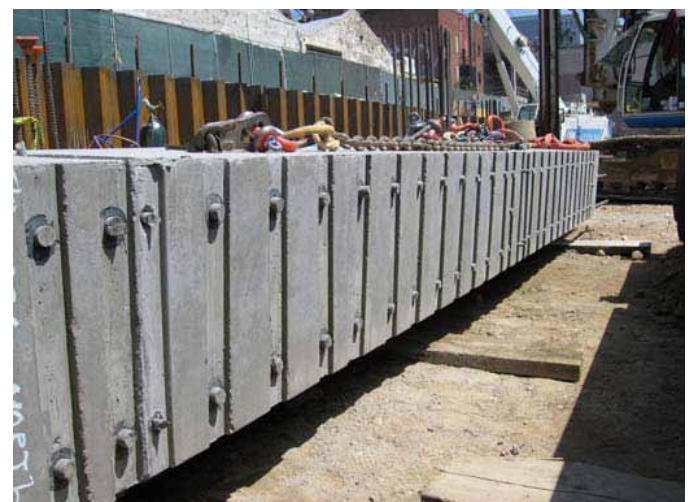
Figura 8: Esquina del núcleo del muro de cortante precolado antes de su instalación
