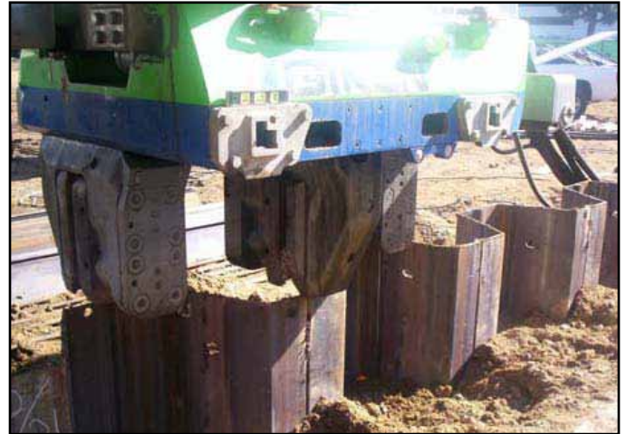
Figura 2: Instalación de pilotes de plancha
