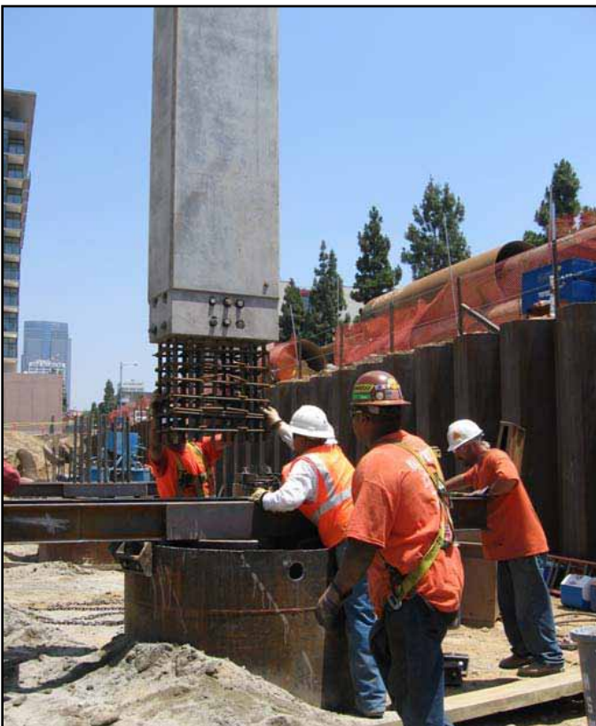
Figura 7: Bajada de la columna precolada de gravedad para colocarla en su lugar
