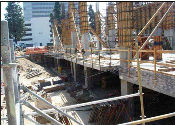
Figura 4: Losa P1 en su lugar, la construcción procedió hacia arriba en la zona de la parte superior hacia la inferior
