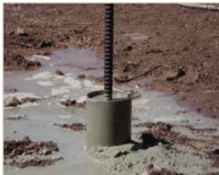
Revestimiento roscado de micropilotes instalado con barras reforzadas 75 ksi completamente roscadas
