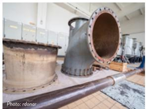
AXIAL HYDRODYNAMIC FLOW PUMP IN WASTEWATER PLANT.
