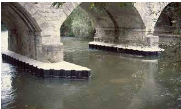
Ataguía de tablestacas de acero permanentes utilizadas como encofrados, y protección en contra de tallones e impactos.
