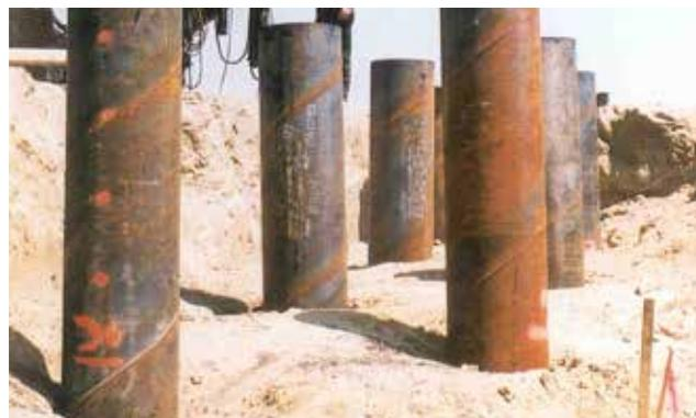
Pilotes de tubo con soldadura en espiral de 24" x 0.500".
