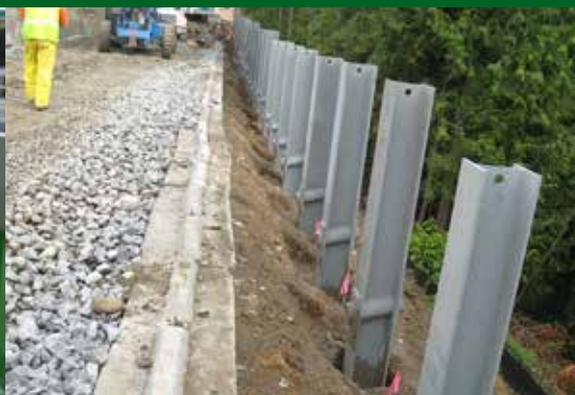
Izquierda: Muro de retención permanente con tablestacas de acero, para el paso a desnivel en Hidalgo, México.
