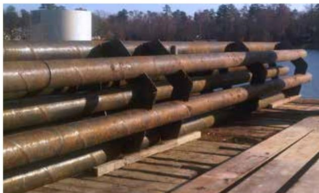
Jaula de refuerzo hecha con tubería con soldadura helicoidal. Barras roscadas adicionales instaladas en el interior del tubo.
