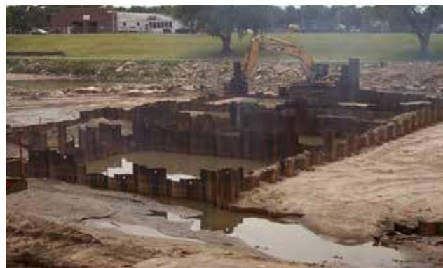
Parrilla de tablestacas de acero-permanentes utilizadas para soportar la carga vertical del Puente de la Lincoln Street y de la Presa en Wichita, Kansas.
