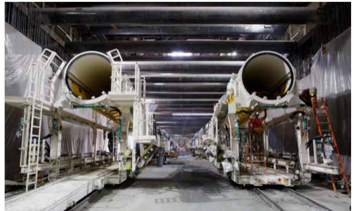
Obra de excavación profunda en la Estación La Brea utilizando vigas de ala ancha
