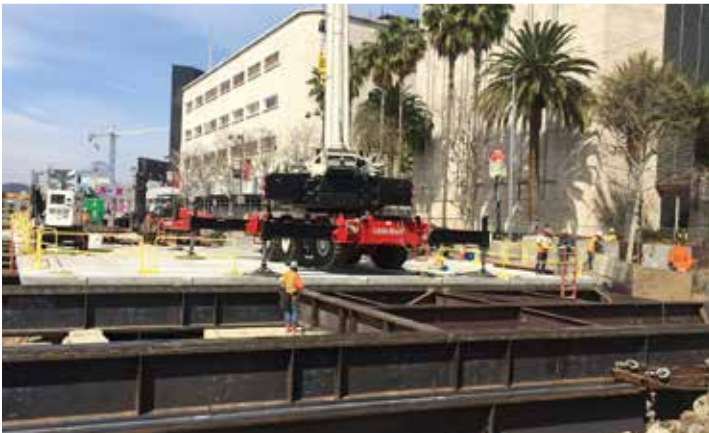
Vigas de ala ancha utilizadas como arriostramiento en la excavación en el centro para el proyecto de la extensión de la Línea Púrpura en Los Ángeles (crédito de imagen: Skanska, Traylor, Shea JV)
